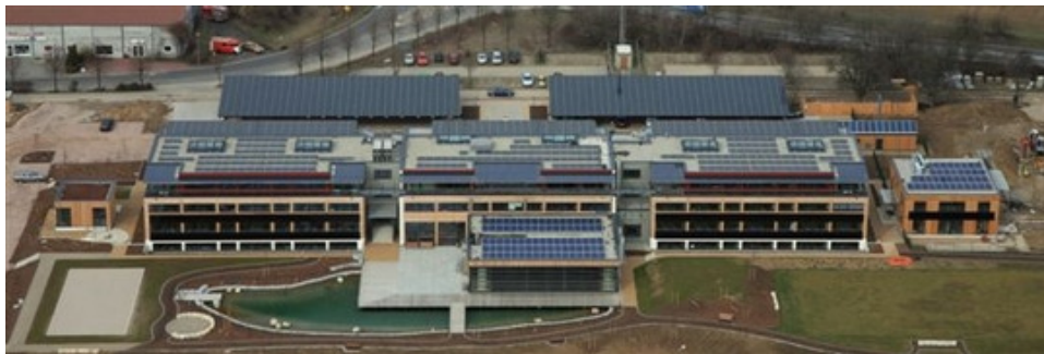
Quelle: Luftaufnahme des Firmensitzes der JUWI Holding AG in Wörrstadt http://www.**
